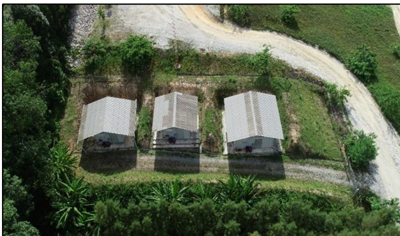
รูปที่ 1.22 มีคลังเก็บดินระเบิดแยกกับคลังเก็บเชื้อปะทุ และมีกำแพงดินกั้นตามแบบกระทรวงกลาโหม
