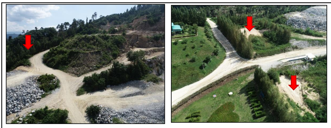
รูปที่ 1.4 สร้างคันทำนบกั้นดิน เพื่อบังคับให้น้ำไหลผ่านปอดักตะกอน
